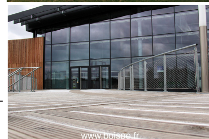
Les tests de glissance pour le platelage en chêne de l'Aquapolis, nouveau centre aquatique du Limousin ont été réalisés à Égletons
