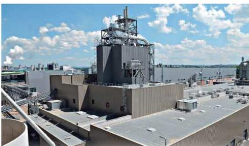
PAVATEX a construit une nouvelle unité industrielle de production de panneaux isolants en fibres de bois. D'une capacité de production de 50 000 tonnes/an, l'usine produit en continu des panneaux rigides de 40 à 300 mm. L'outil industriel est « le plus moderne d'Europe sur son secteur ».
