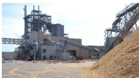
La ligne de production de Pavatex utilise la vapeur à haute pression dégagée par l'usine de Norske Skog pour sécher la matière première. La vapeur à basse pression sert à défibrer le bois, puis à activer le liant de l'isolant.
