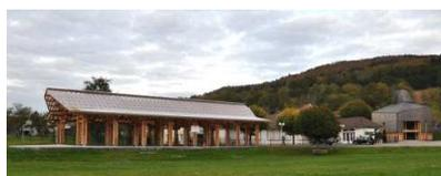
Construction d'une halle sur la place de Tendon, projet bois réalisé en filière courte, avec la réinterprétation d'un système constructif traditionnel : l'encorbellement.
