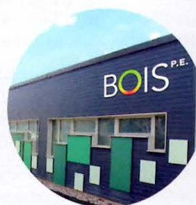
Façade des ateliers du centre de formation Bois P.E.
