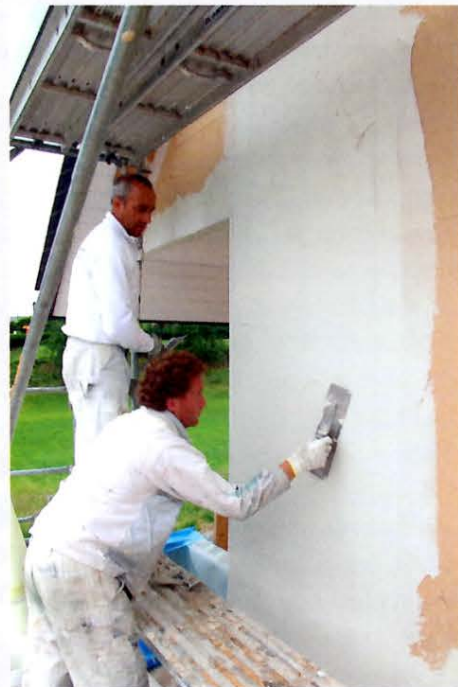
Enduit sur fibre de bois.
