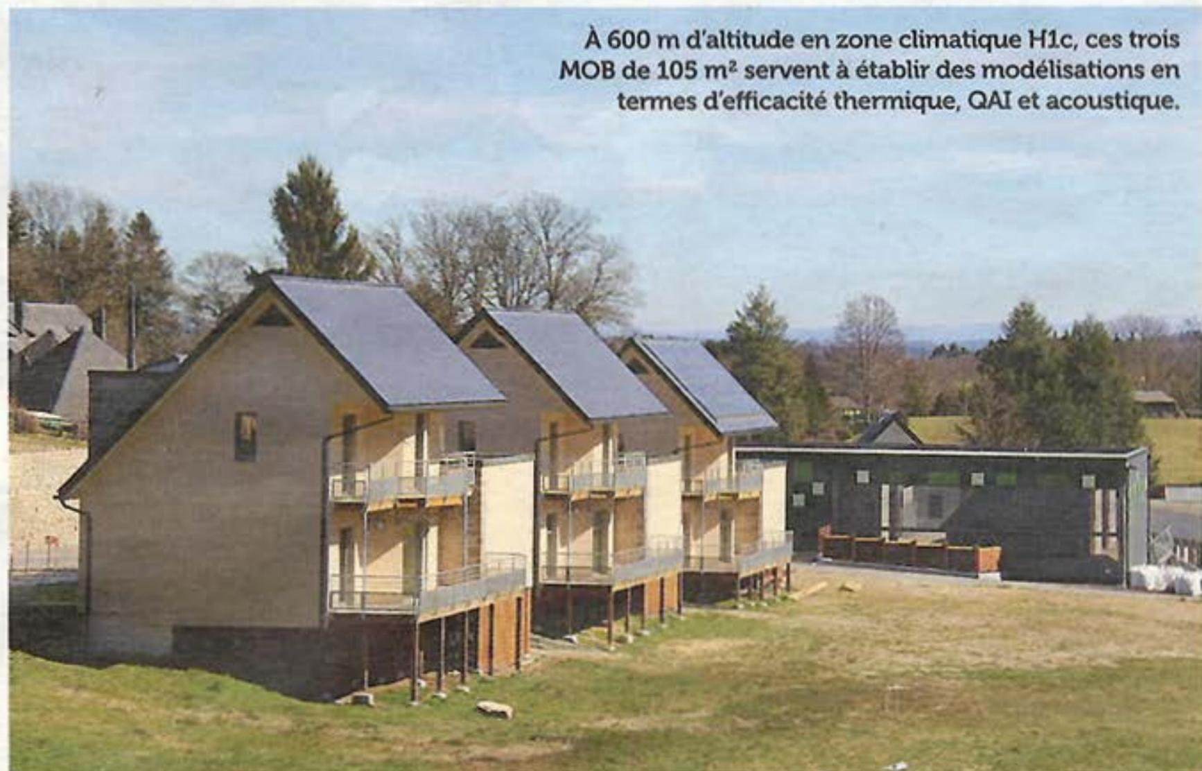
À 600 m d'altitude en zone climatique H1c, ces trois MOB de 105 m<sup>2</sup> servent à établir des modélisations en termes d'efficacité thermique, QAI et acoustique.
