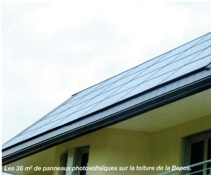
Les 36 m<sup>2</sup> de panneaux photovoltaïques sur la toiture de la Bepos.
